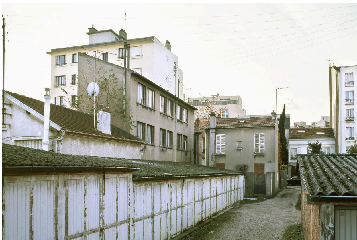
L'atelier des machines et de l'atelier principal, vus depuis la cour de la fonderie Piattino.
