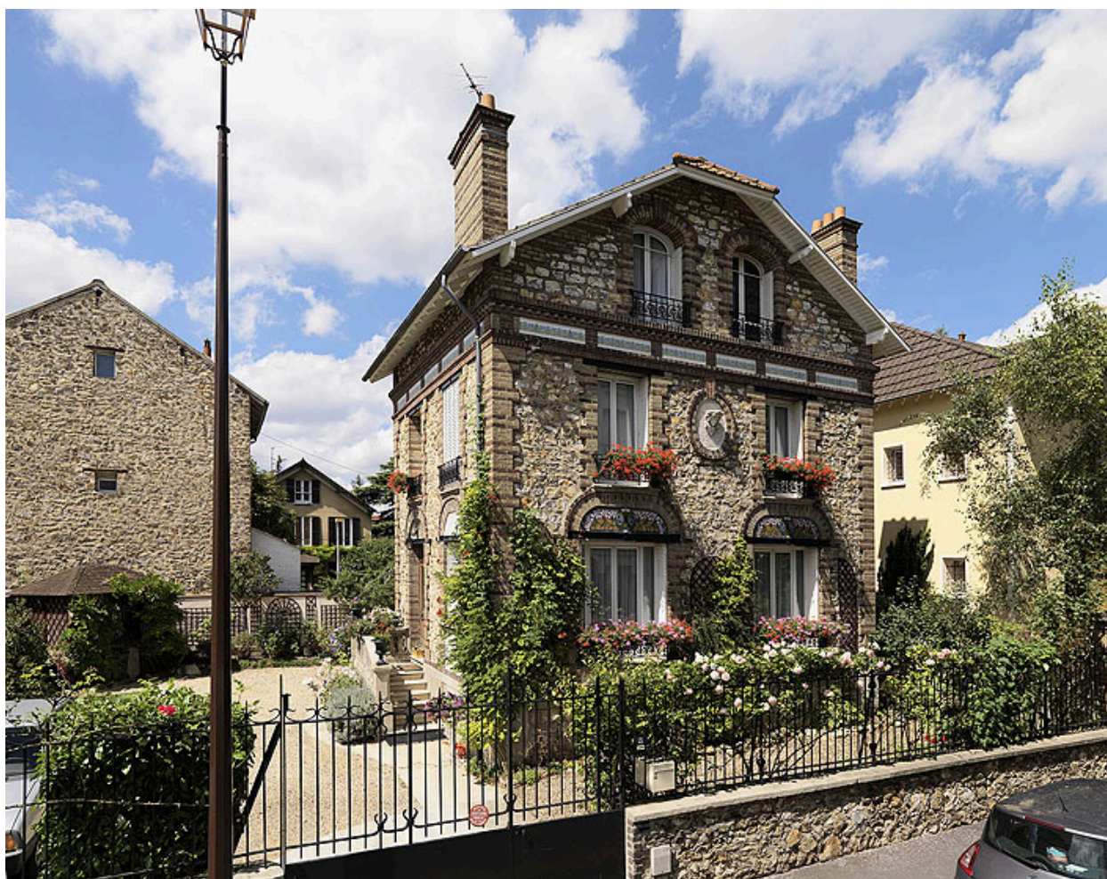
Vue d'ensemble de la façade antérieure.
