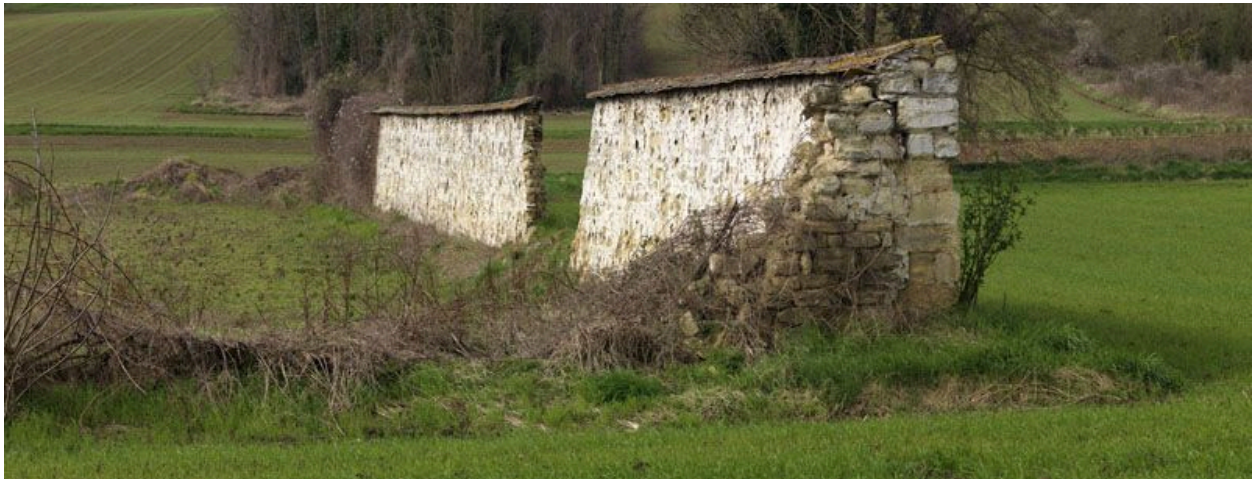
Maurecourt. Un ancien mur à chasselas.
