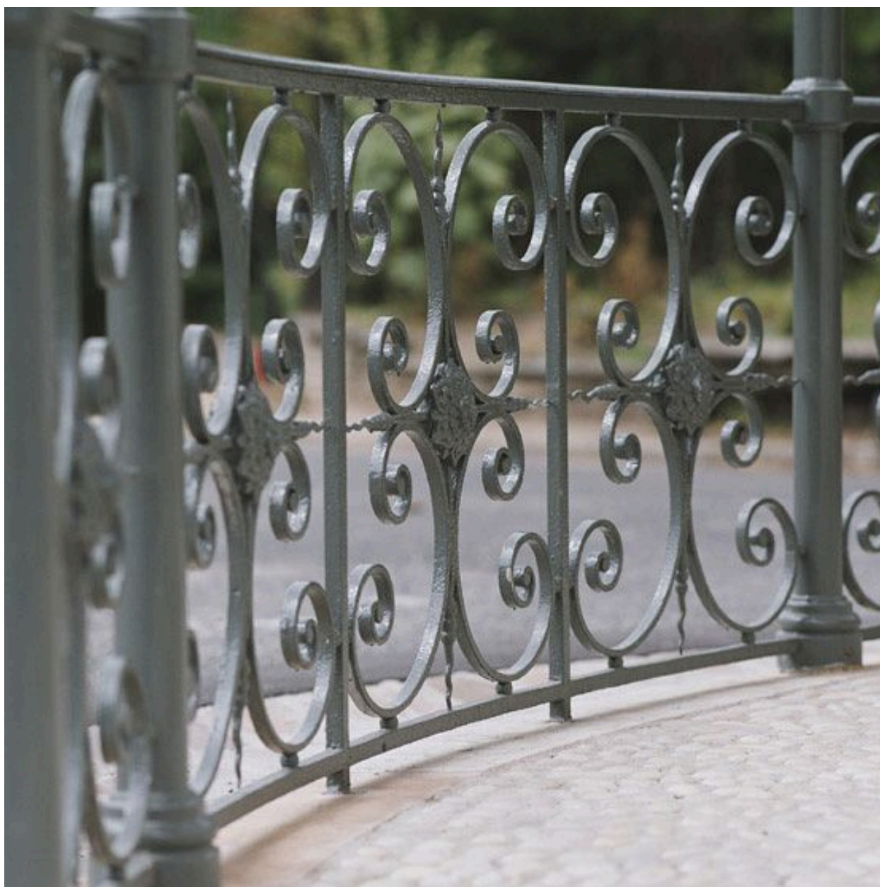
Détail de la rambarde métallique sur le pourtour de la fabrique.
