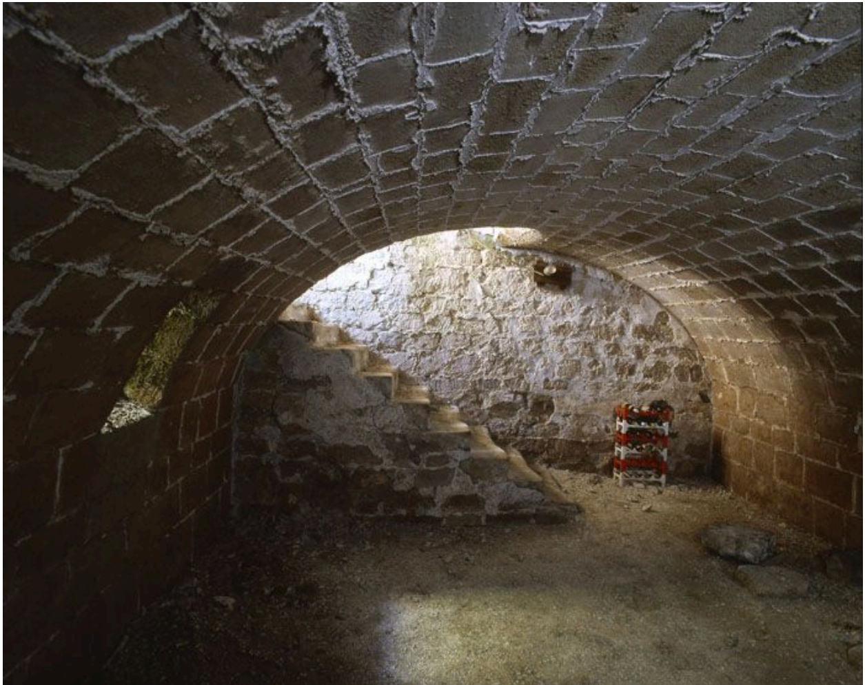
La cave et son escalier d'accès.
