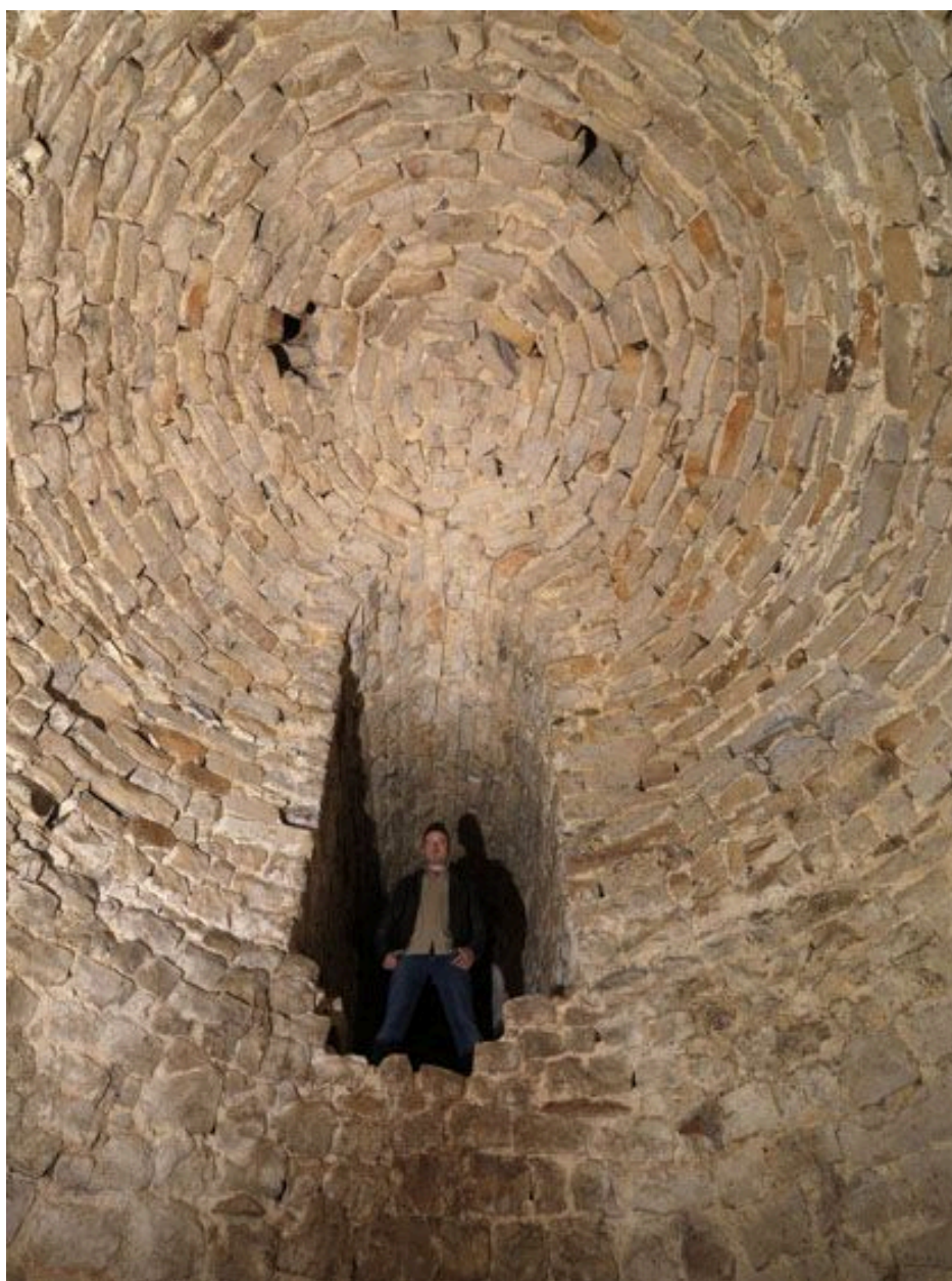
La coupole de la cuve et le couloir d'accès.
