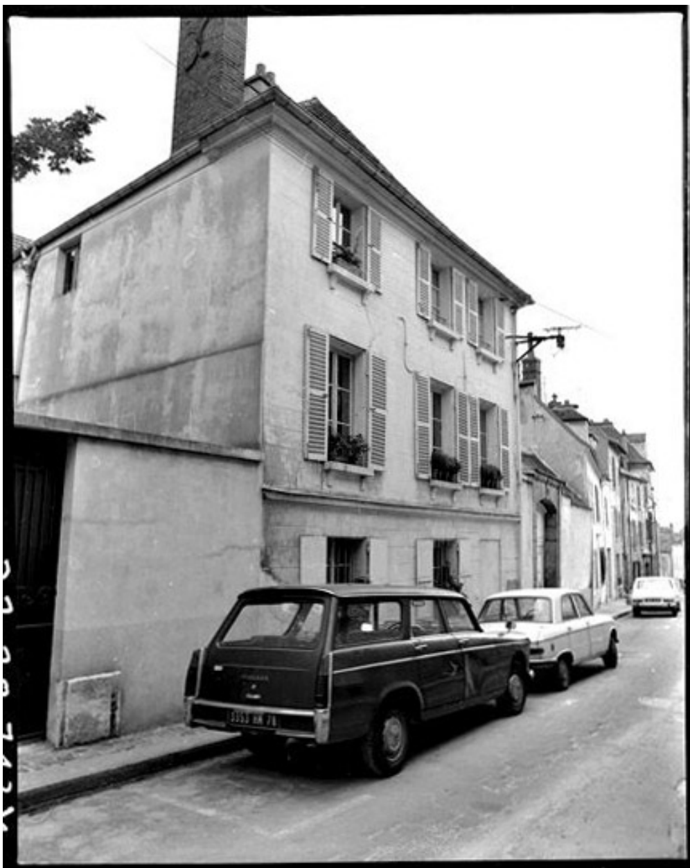
Hôtel particulier, Sangle (rue de la) 44. La façade de l'aile sur rue.
