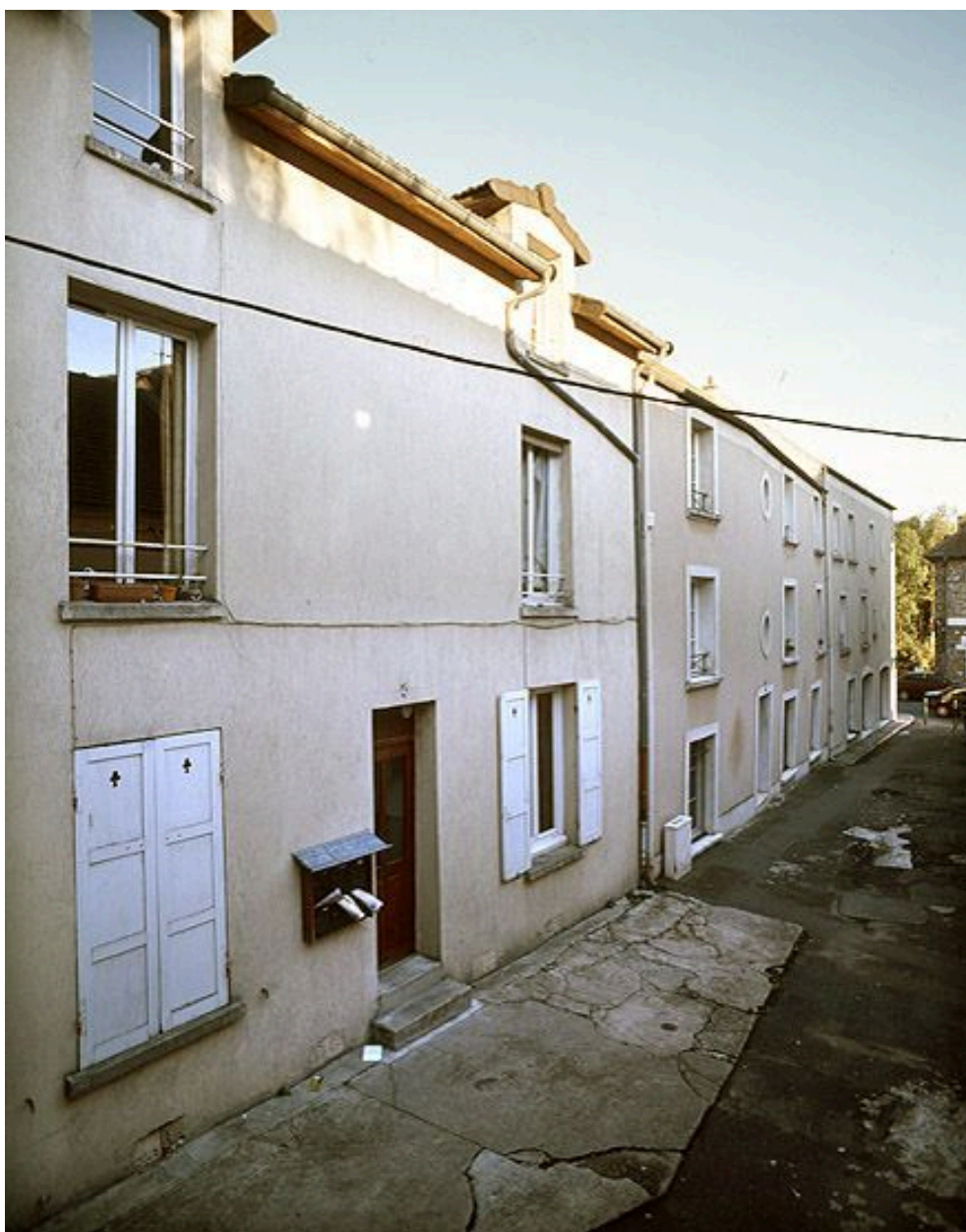
Vue de la façade occidentale de la cour.
