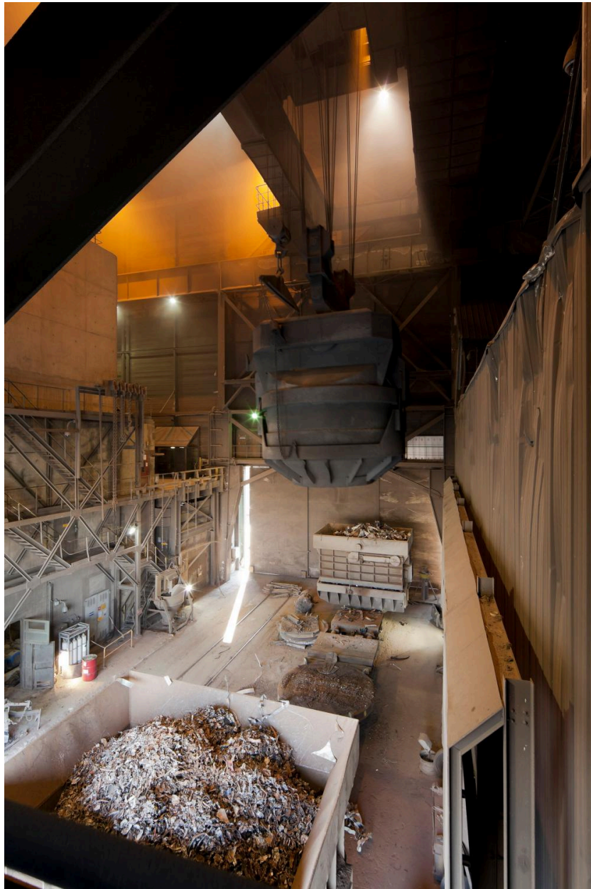
Halle du four, déplacement du panier. (réf. Département Seine-et-Marne : IVD77_2013_77_00271_NUCA)
