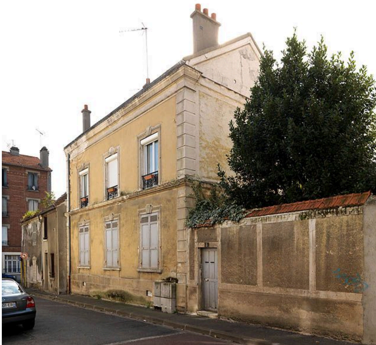
Orly, maison, 5 rue Ivan Prévost. Vue d'ensemble.
