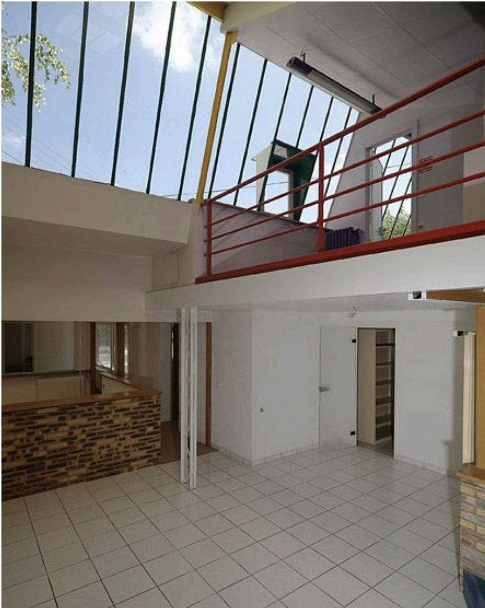
Atelier de fabrication, travées reconverties en bureaux par la société Mafco.
