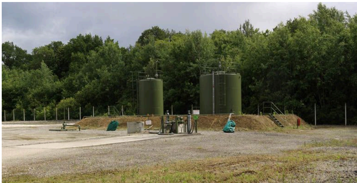
Vue générale des cuves de stockage et de la zone de chargement pour camions citernes.
