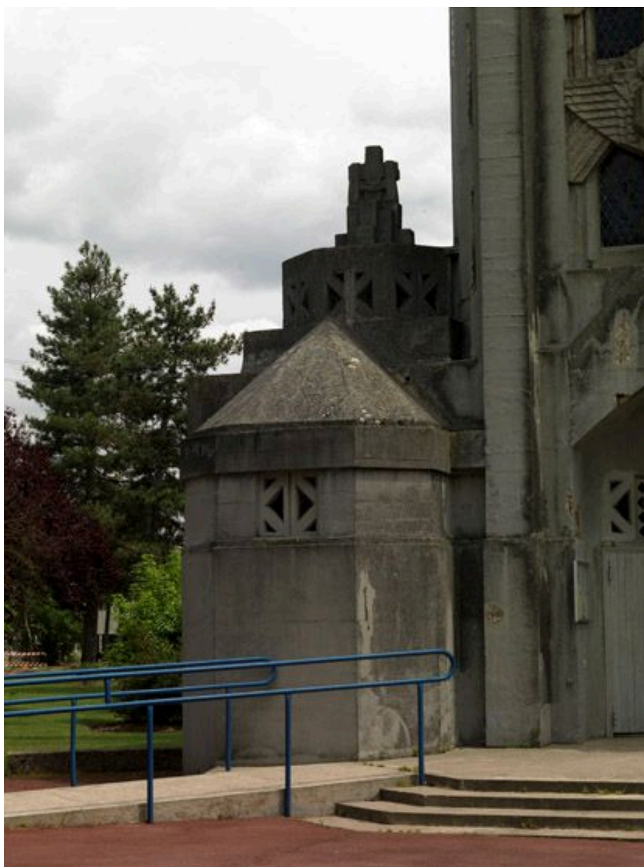
Vue extérieure de la chapelle Saint Joseph.
