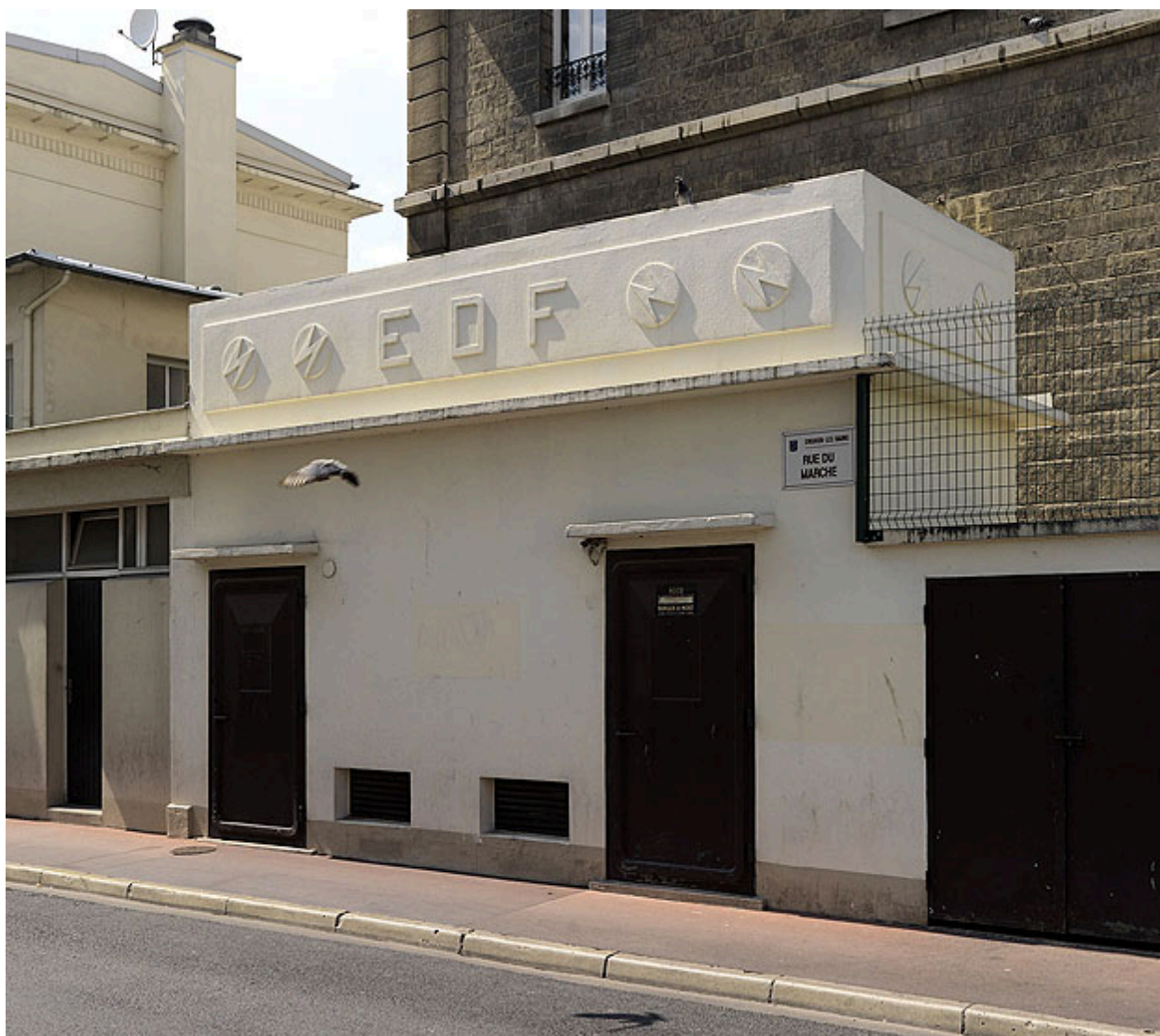
Vue du transformateur.
