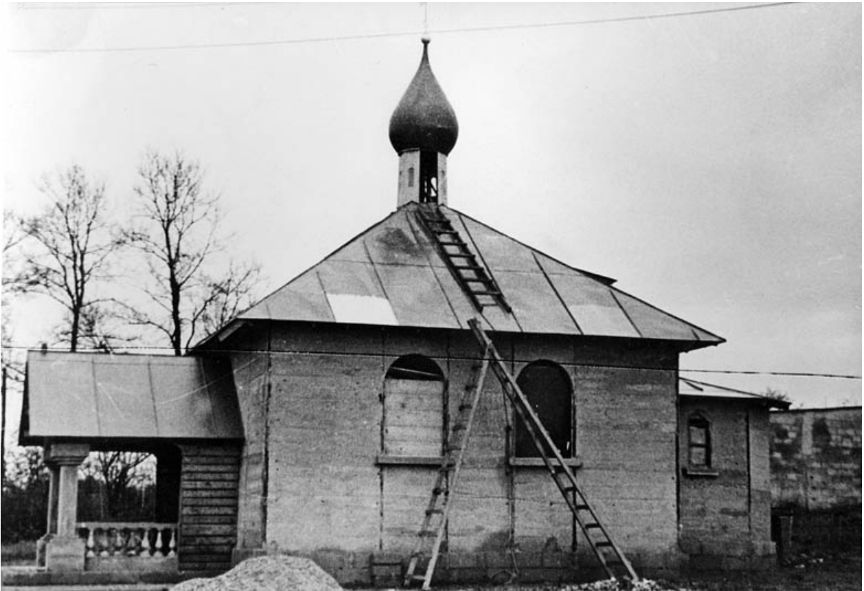
Photo ancienne. Construction de l'église orthodoxe en 1937-1938 sur les plans de J.Papandopoulos, ingénieur de la société PIC de Fontainebleau.
