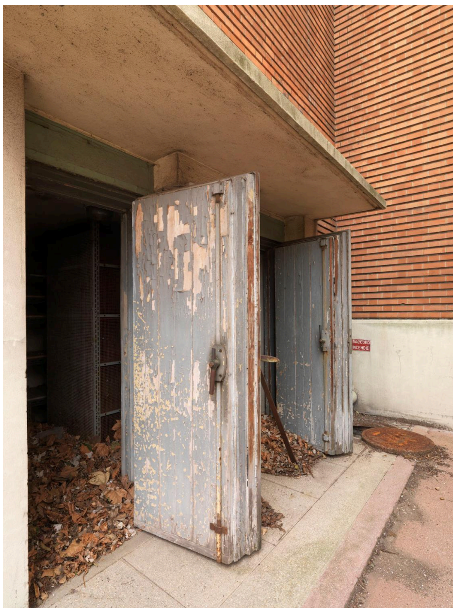
Site Sanofi. Vue des portes blindées. Bâtiment désaffecté.
