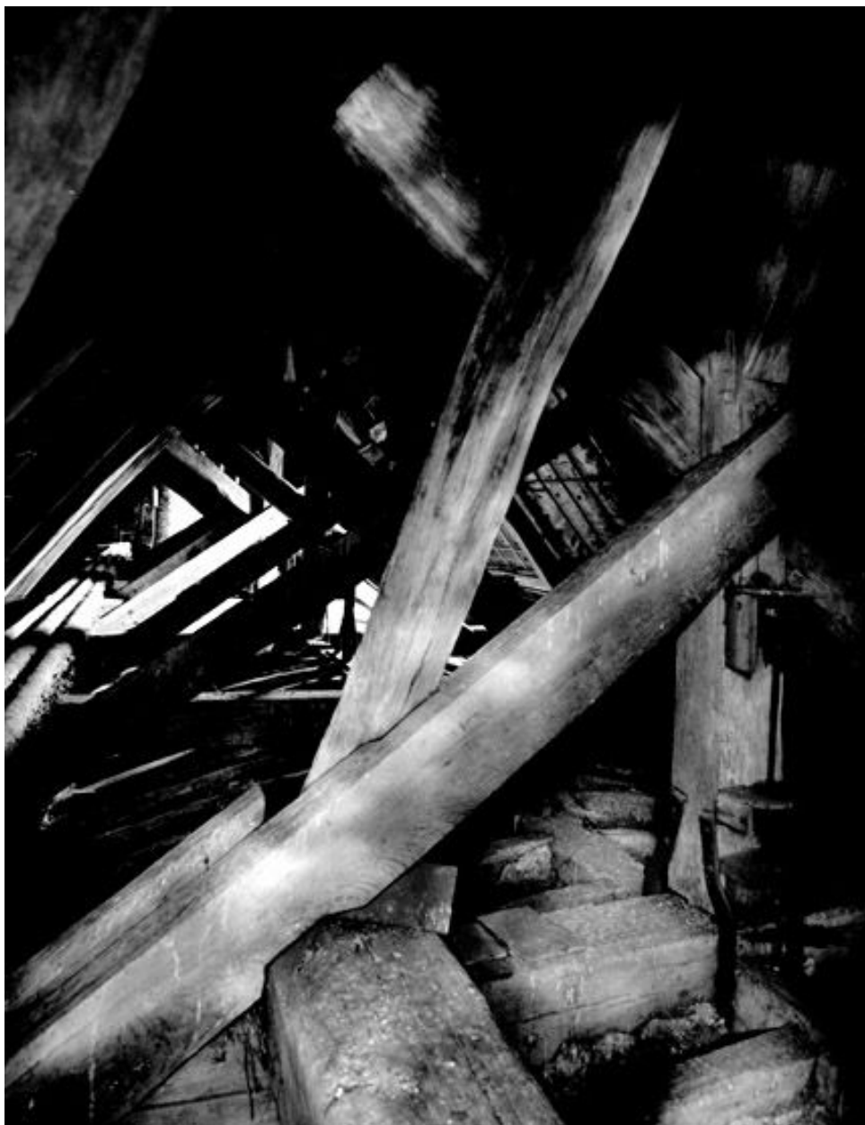
La charpente de la chapelle.
