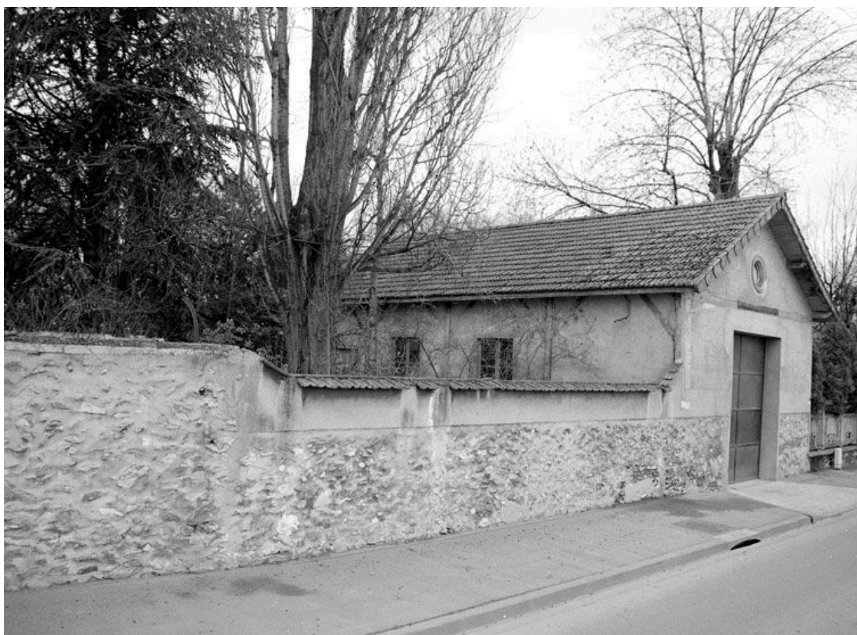
Remise à bateau, 25 quai de Champagne.
