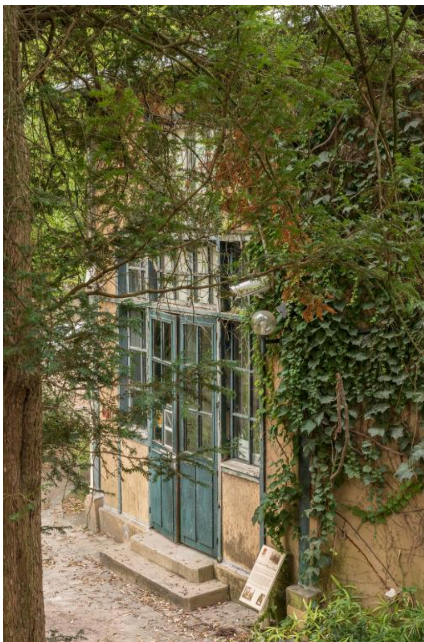
Vue latérale de la façade
