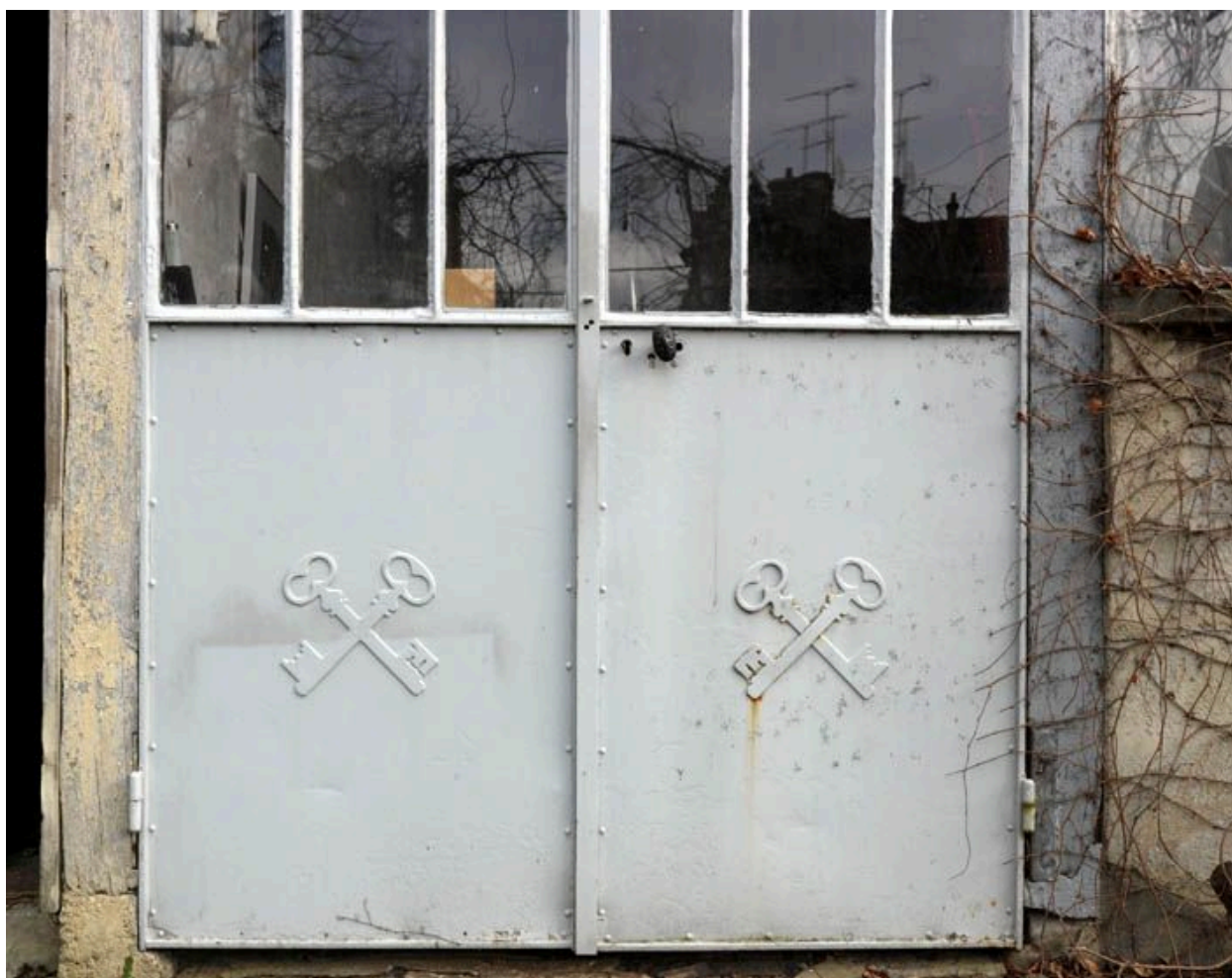
Ancien atelier du serrurier, détail de la porte d'accès.
