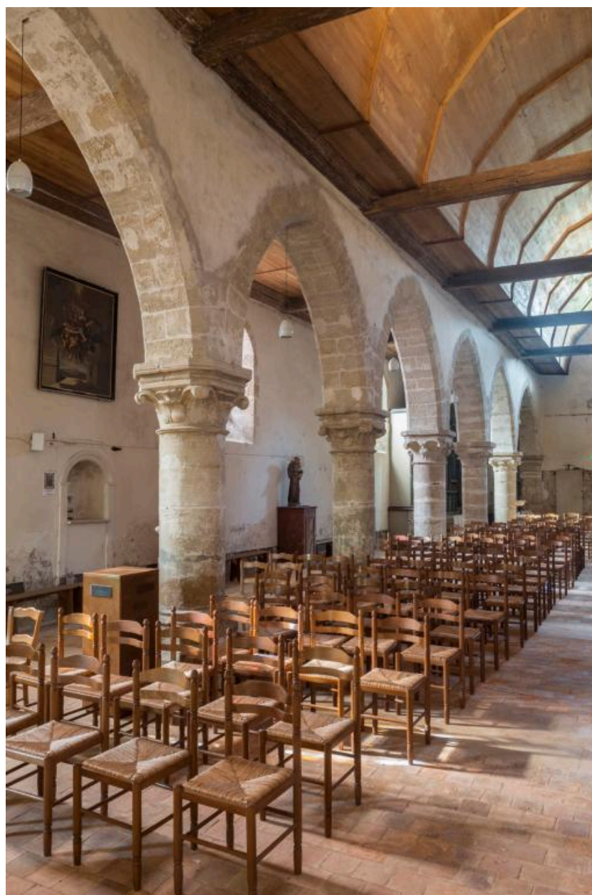
Vue du collatéral sud depuis le chœur.
