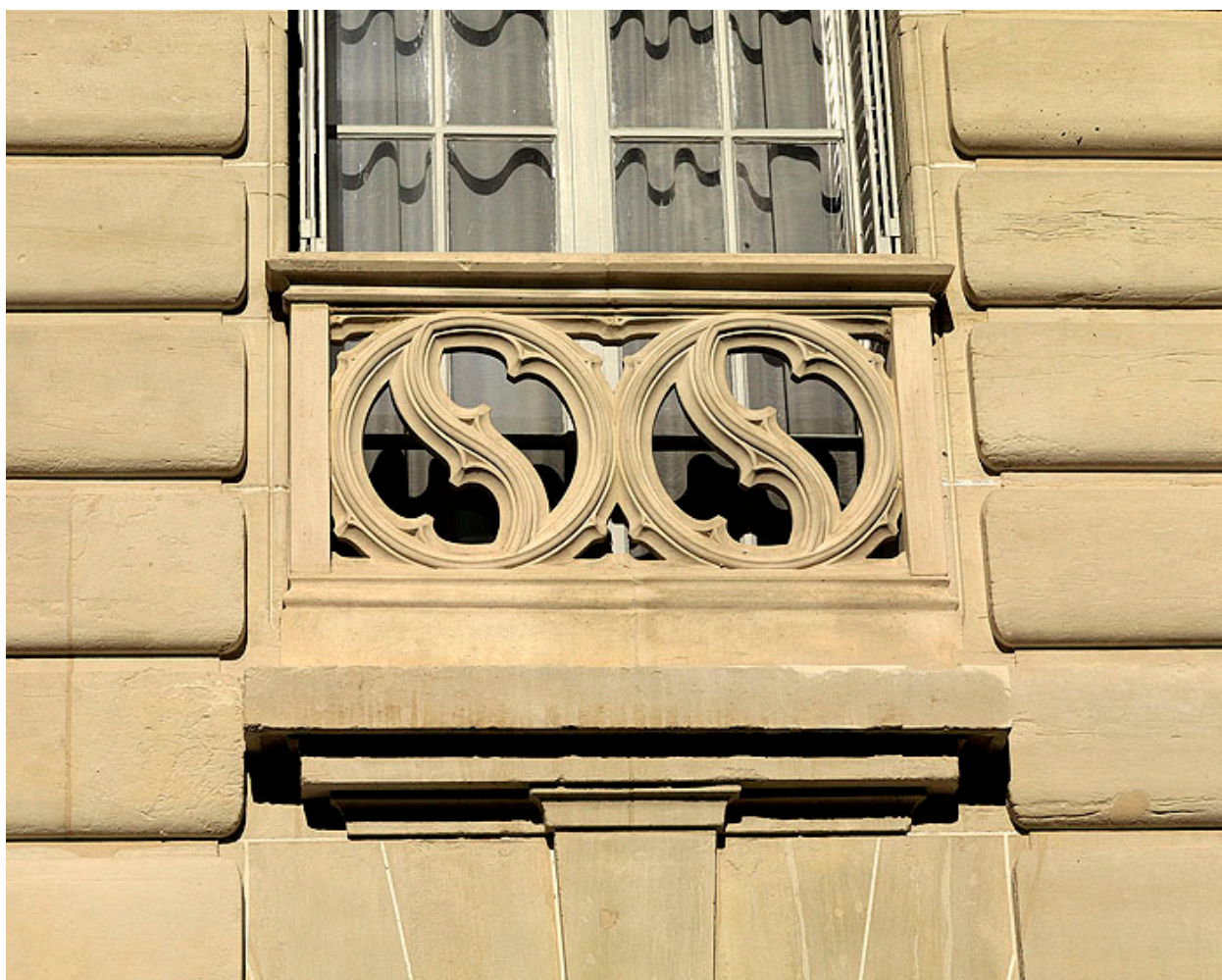
Détail des balustres d'une baie, traitées en remplage de pierre.
