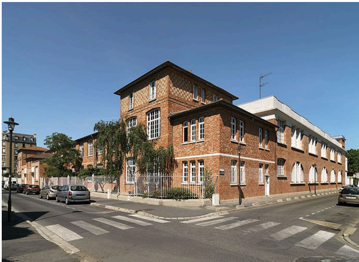
92, Gennevilliers, école primaire dite groupe scolaire Pasteur, 60 rue Richelieu. Façade antérieure de briques polychromes.
