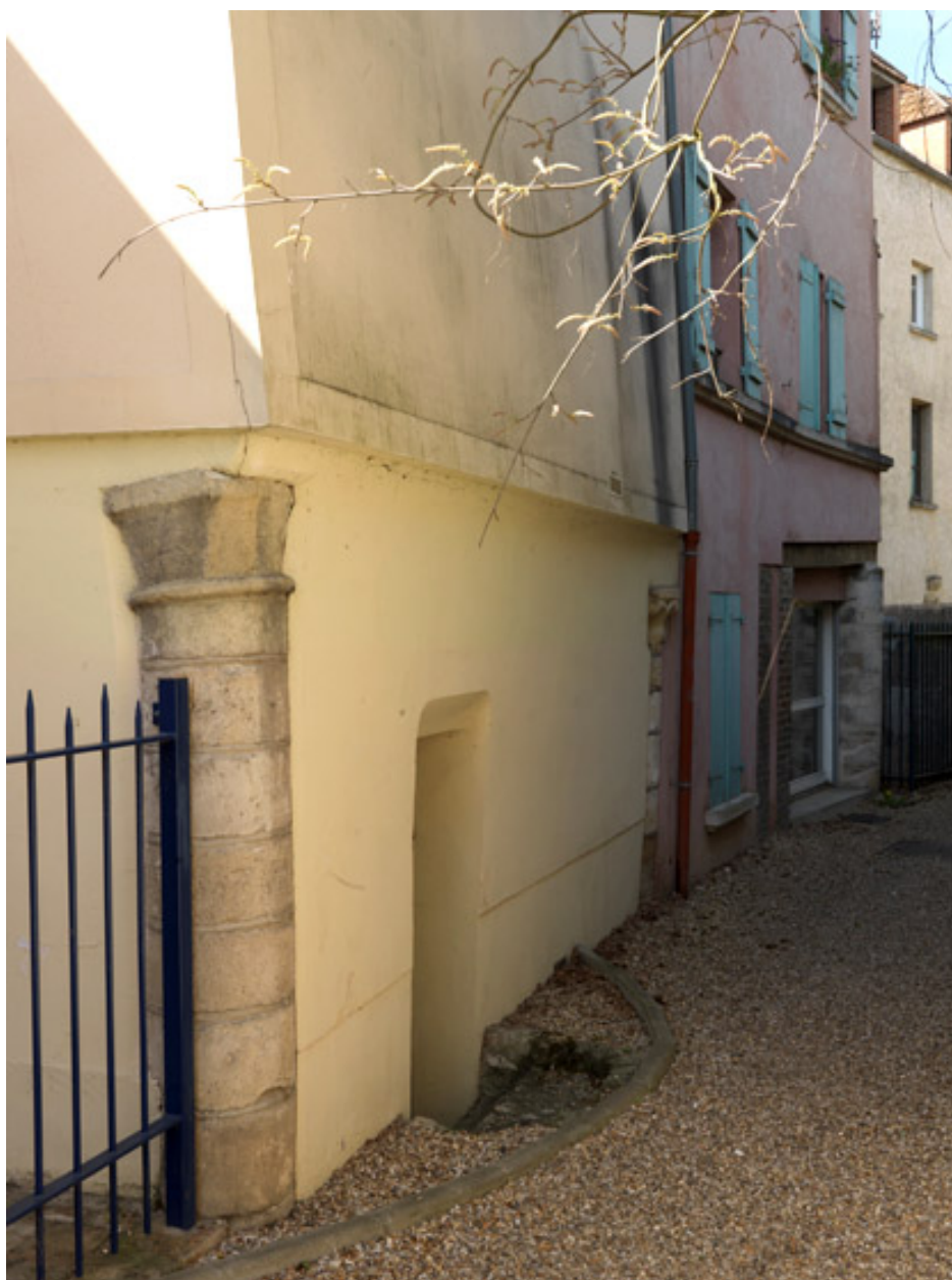
Vestiges d'encorbellement et de fosses, rue Basse des tanneries.
