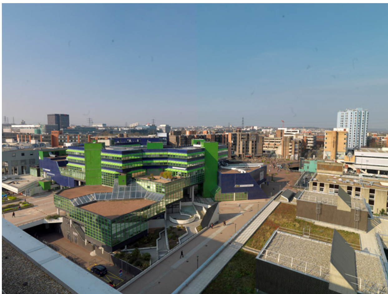
Le centre culturel et administratif André Malraux vu depuis le toit de la préfecture.
