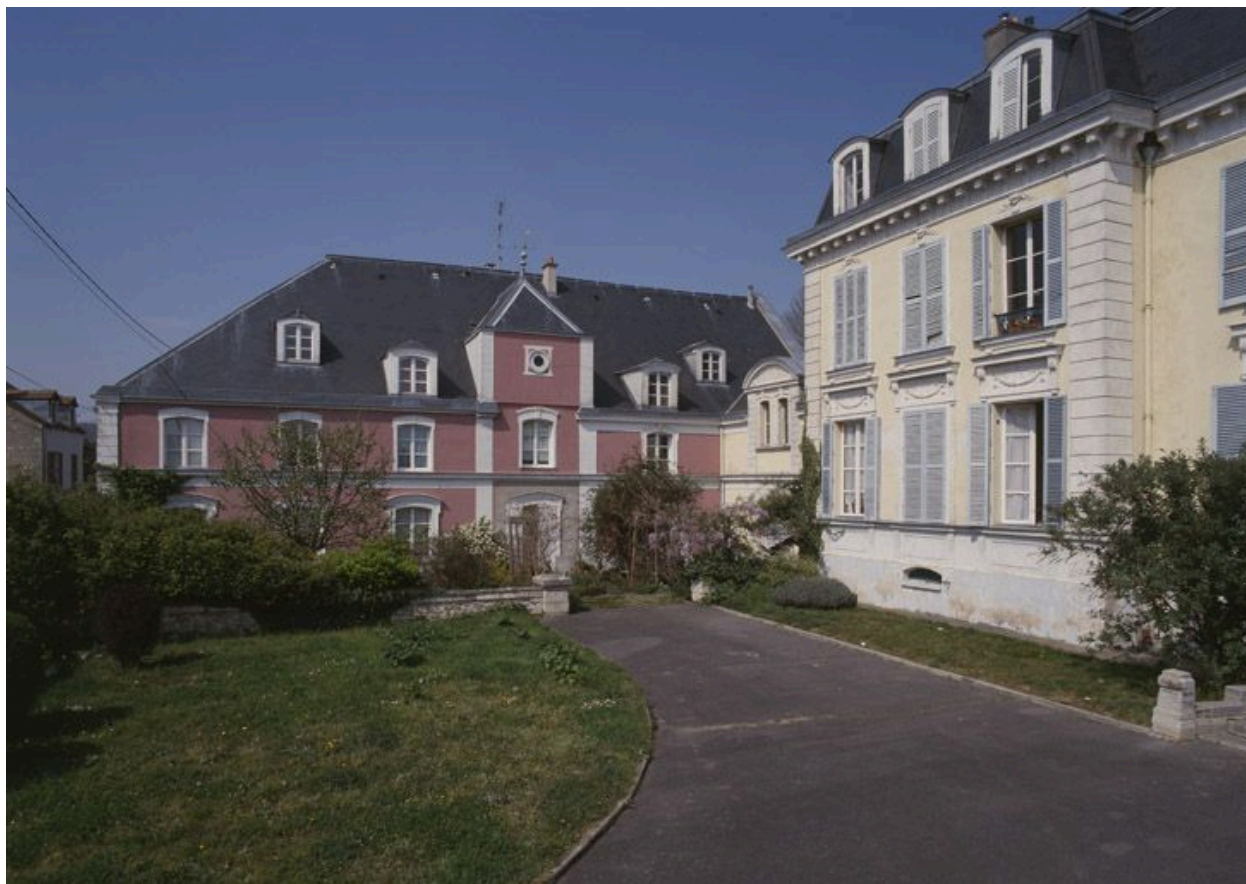
Façade sur la cour du bâtiment des communs perpendiculaire au château.
