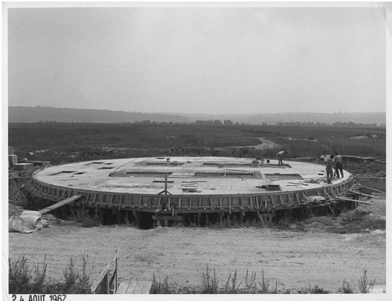
Construction de la base d'une des unités de la chaufferie géothermique de Meaux-Beauval. 24 août 1967. (OPAC Meaux)
