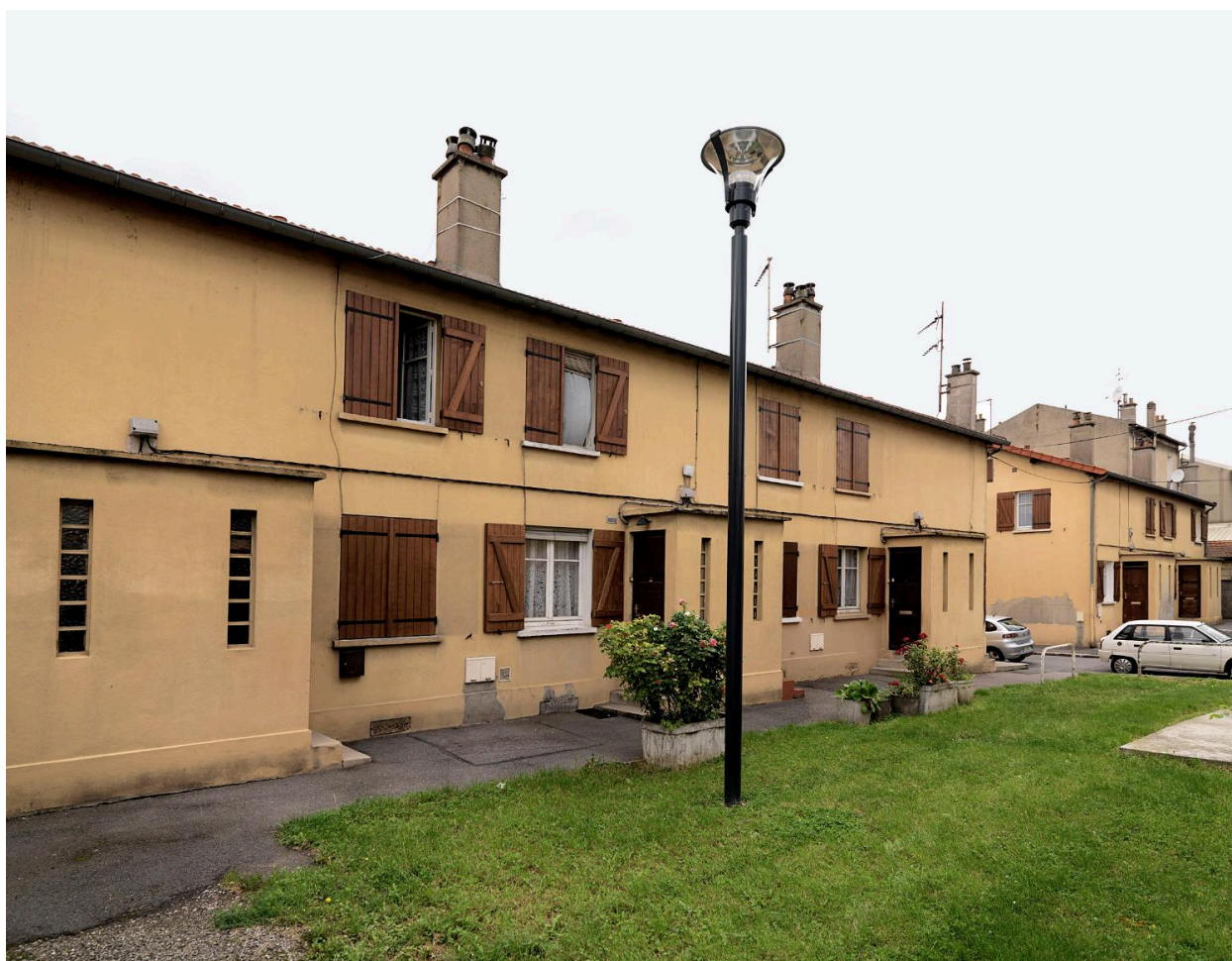
Cité des Mares. Vue d'un bâtiment.
