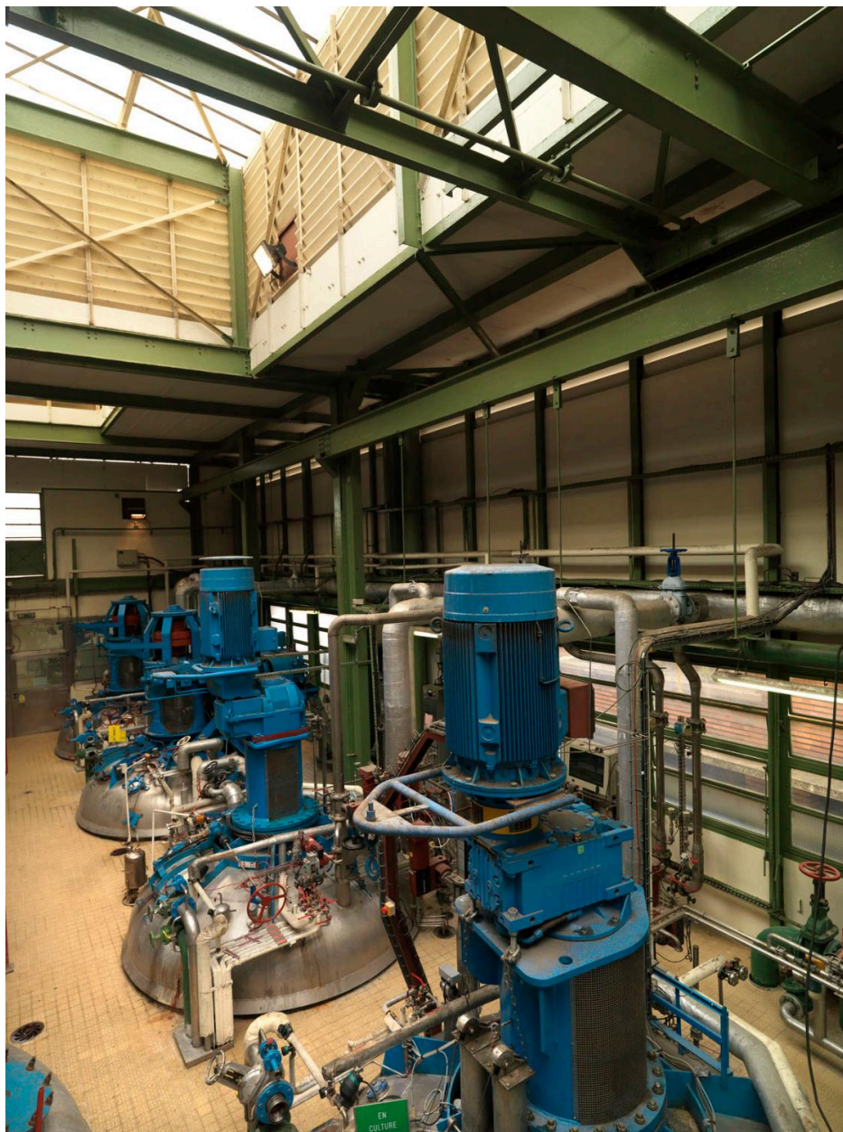
Site Sanofi. Bâtiment de transformation. Cuves.
