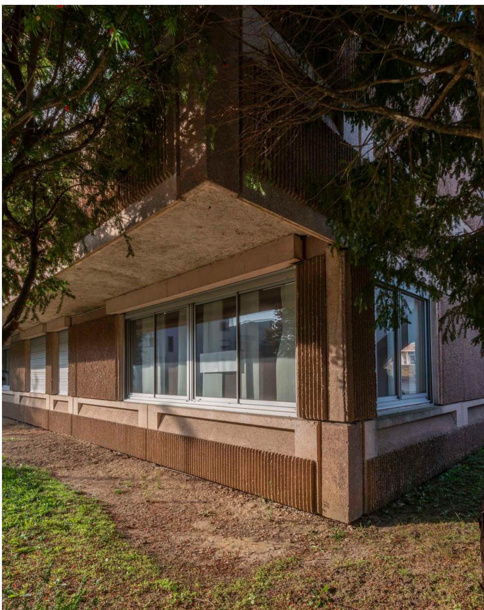
L'angle du bâtiment de l'administration.
