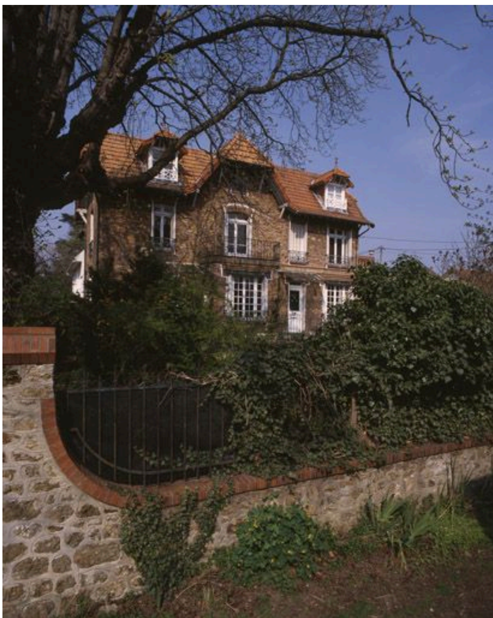
Vue d'ensemble d'une des maisons de l'avenue Libert.
