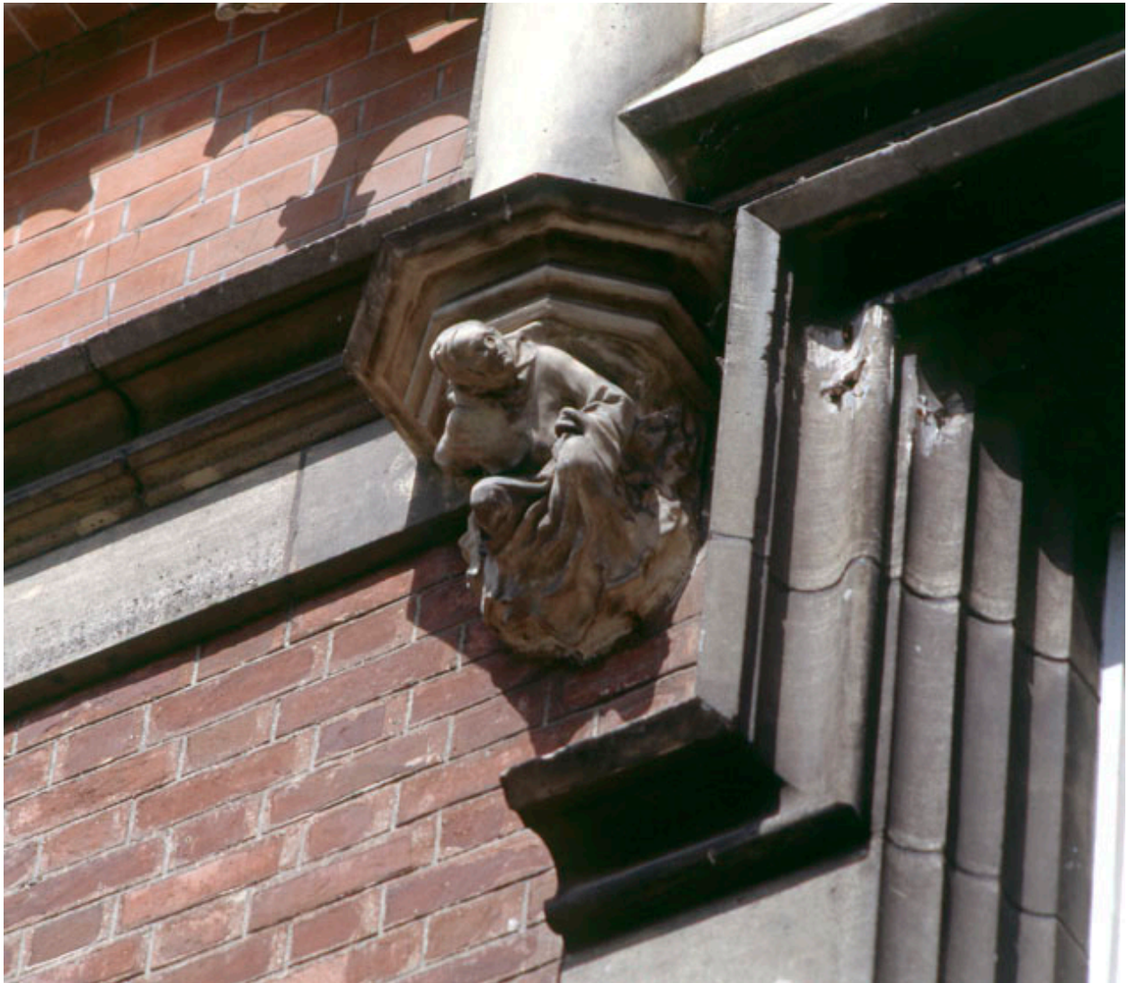
Façade sur jardin, pavillon central, composition architecturale des parties hautes : détail d'un culot sculpté orné d'un personnage.
