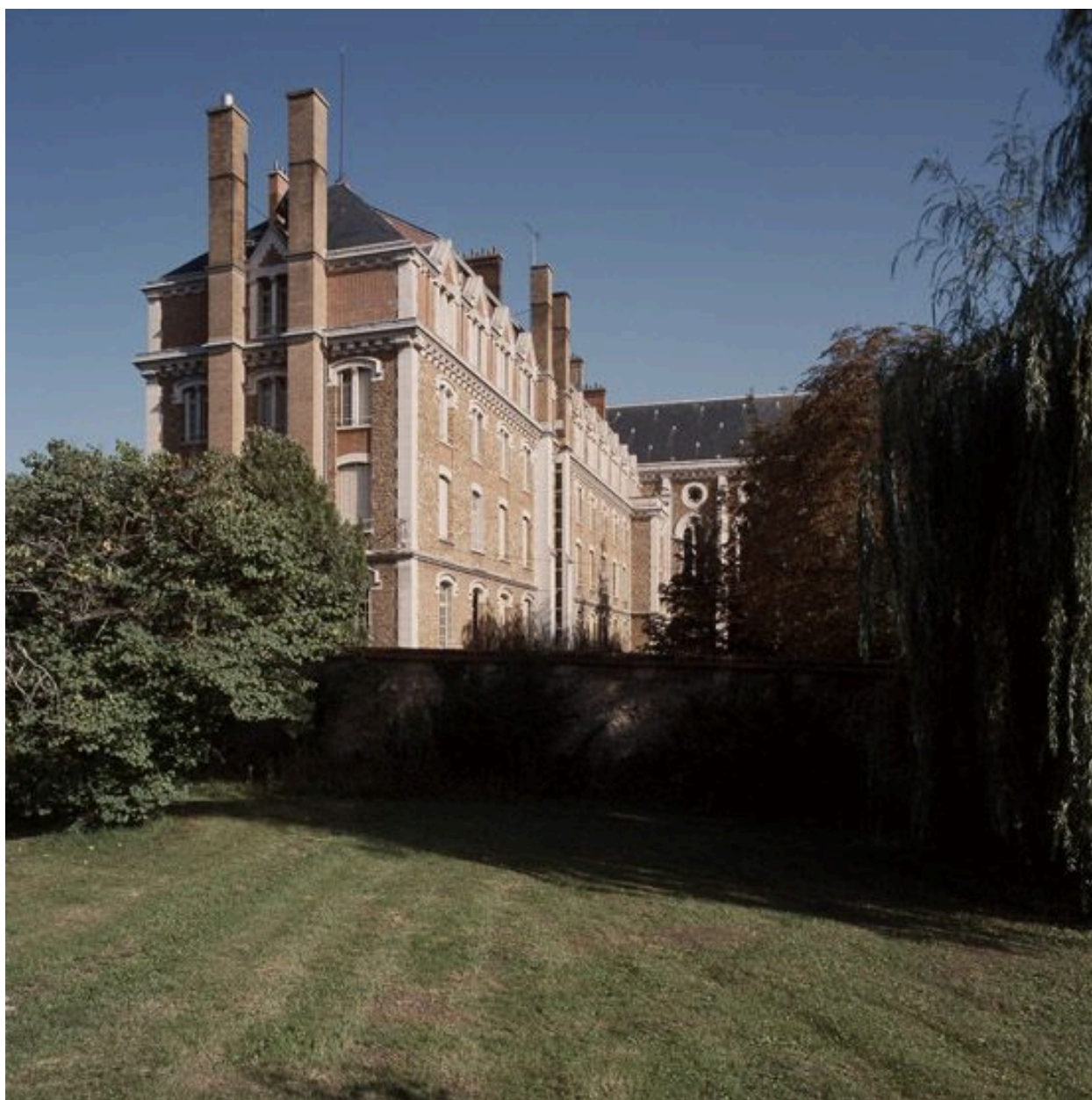
Vue latérale du bâtiment de la communauté ou pavillon Saint-Michel relié à la chapelle.
