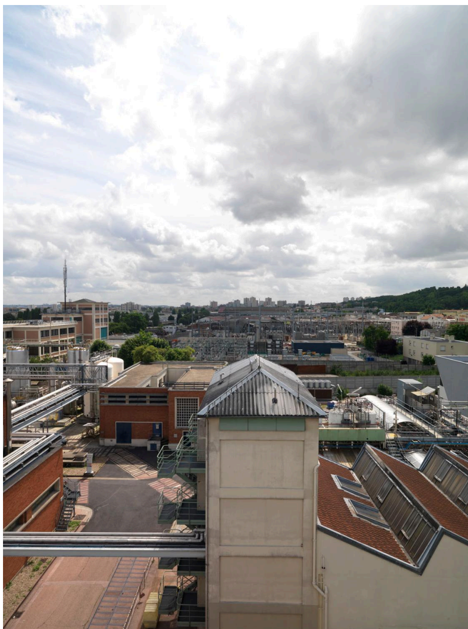
Site Sanofi. Vue des toits.
