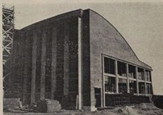
Fig. 4. — Vue de la rotonde de Longueau en cours d'achèvement.
