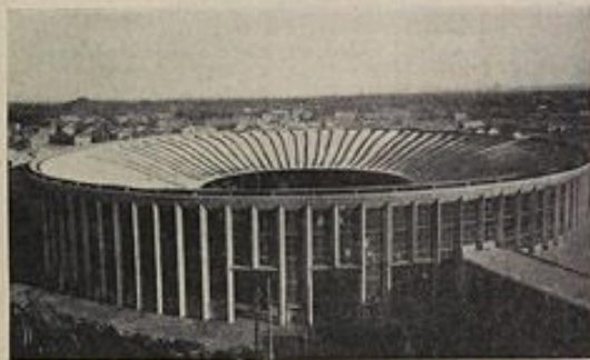
Fig. 3. — Rotonde à machines d'Avignon. On remarque dans la corniche le déflecteur statique et, au-dessus des voûtes, les gaines d'évacuation.
