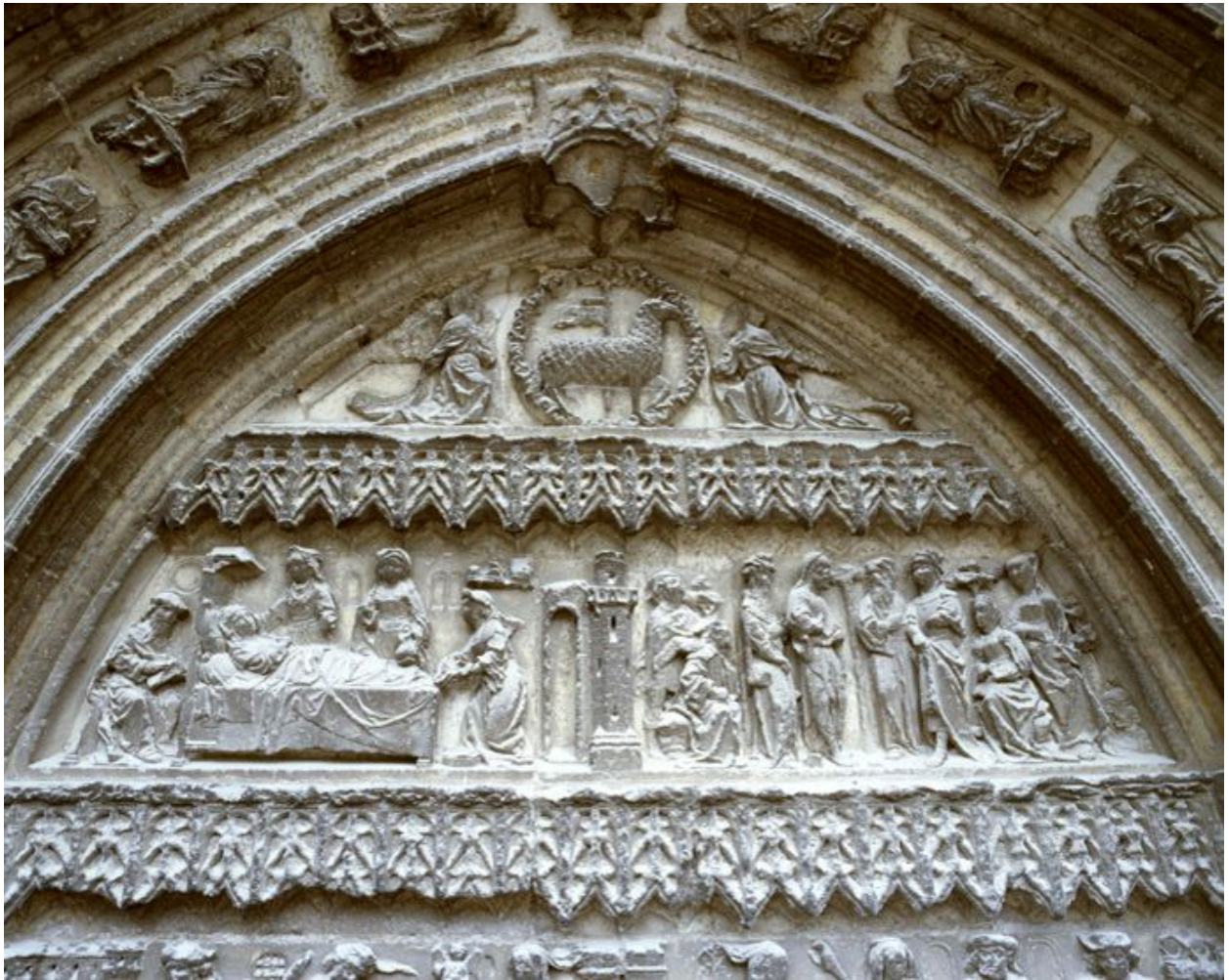
Les sculptures du portail Saint-Jean-Baptiste, vues depuis l'échafaudage dressé pour la restauration de la base de la tour nord (2008) : les registres supérieurs du tympan.
