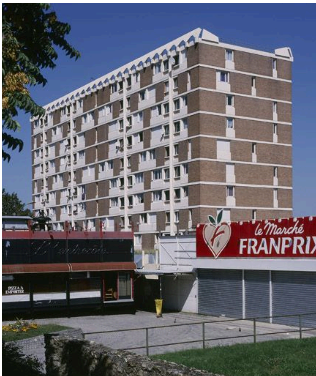
Vue d'ensemble de l'immeuble R+9 ; au premier plan, le centre commercial de la Patte d'Oie.
