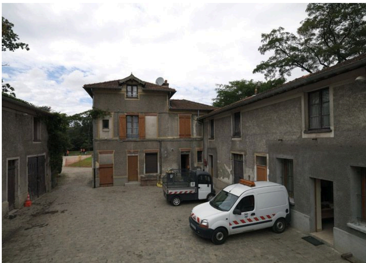
La cour des communs, avec au fond la façade postérieure de la maison du gardien.
