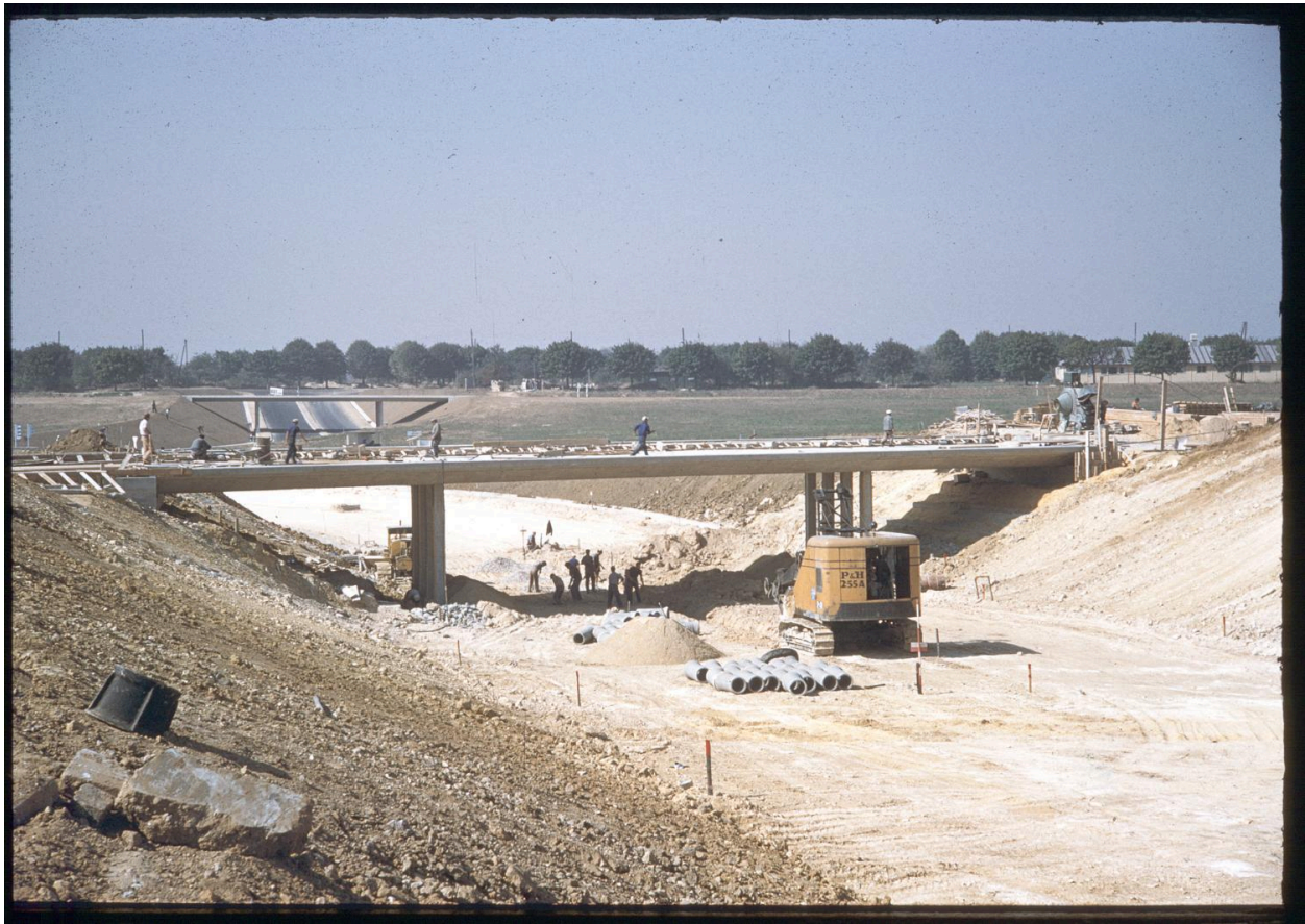
1956 1960 Construction du nouveau tracé de la Nationale 7.
