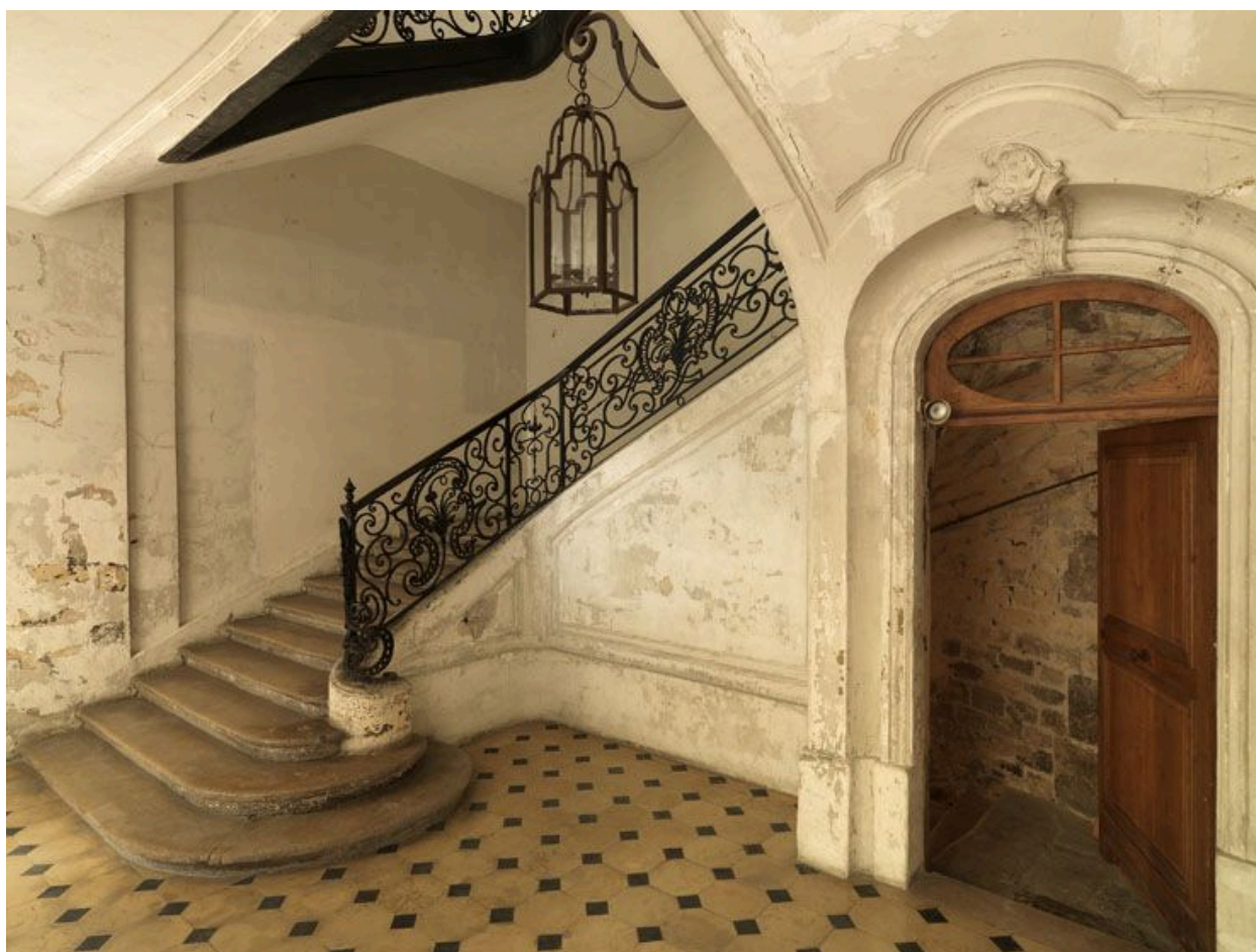
Escalier principal : la première volée et la descente de cave.
