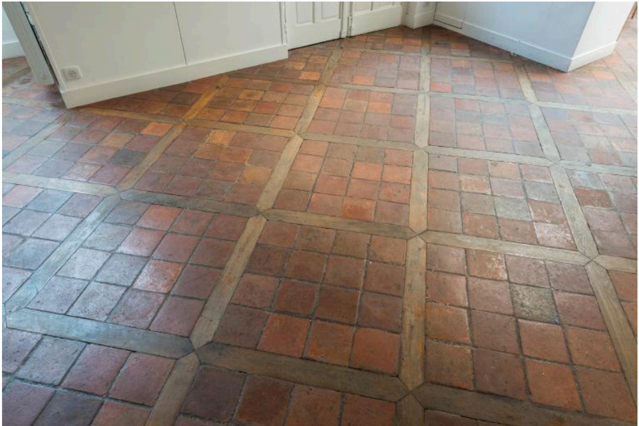
Détail du pavement au rez-de-chaussée du bâtiment Fernand Léger
