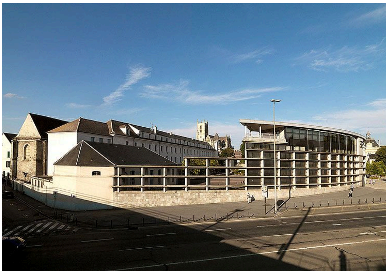
La façade du lycée sur le cours de Verdun.
