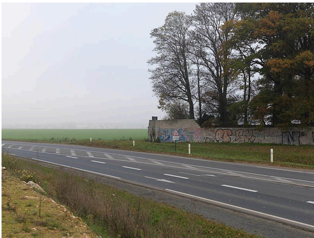
95, Vémars, rue des Vignolles. Vue générale avec champs, route et au fond Saint-Witz. Sur la droite le mur d'enceinte du château de Vémars.
