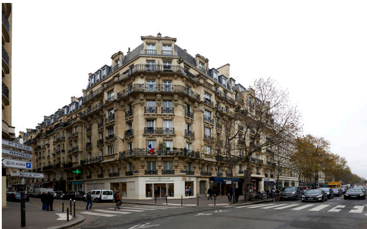
Vue de la façade prise depuis l'avenue du Général-Leclerc.
