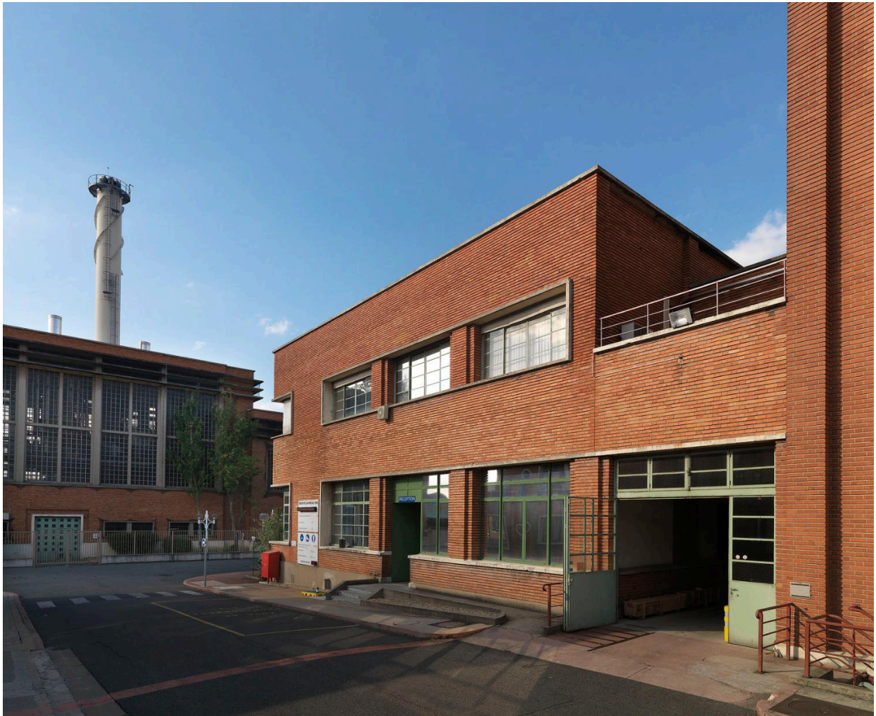
Site Sanofi, vue du bâtiment renfermant les cuves de fermentation. Bâtiment de la chaufferie en fond.
