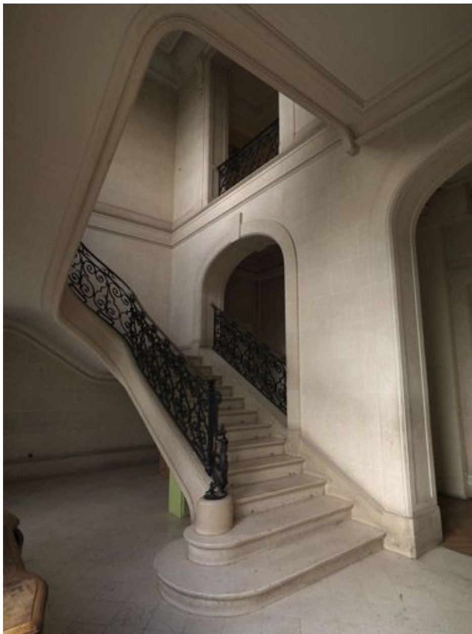
Vue d'ensemble de la cage d'escalier.
