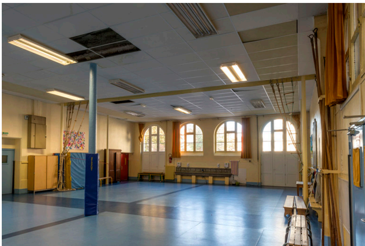
Vue des baies éclairant la salle de gymnastique.
