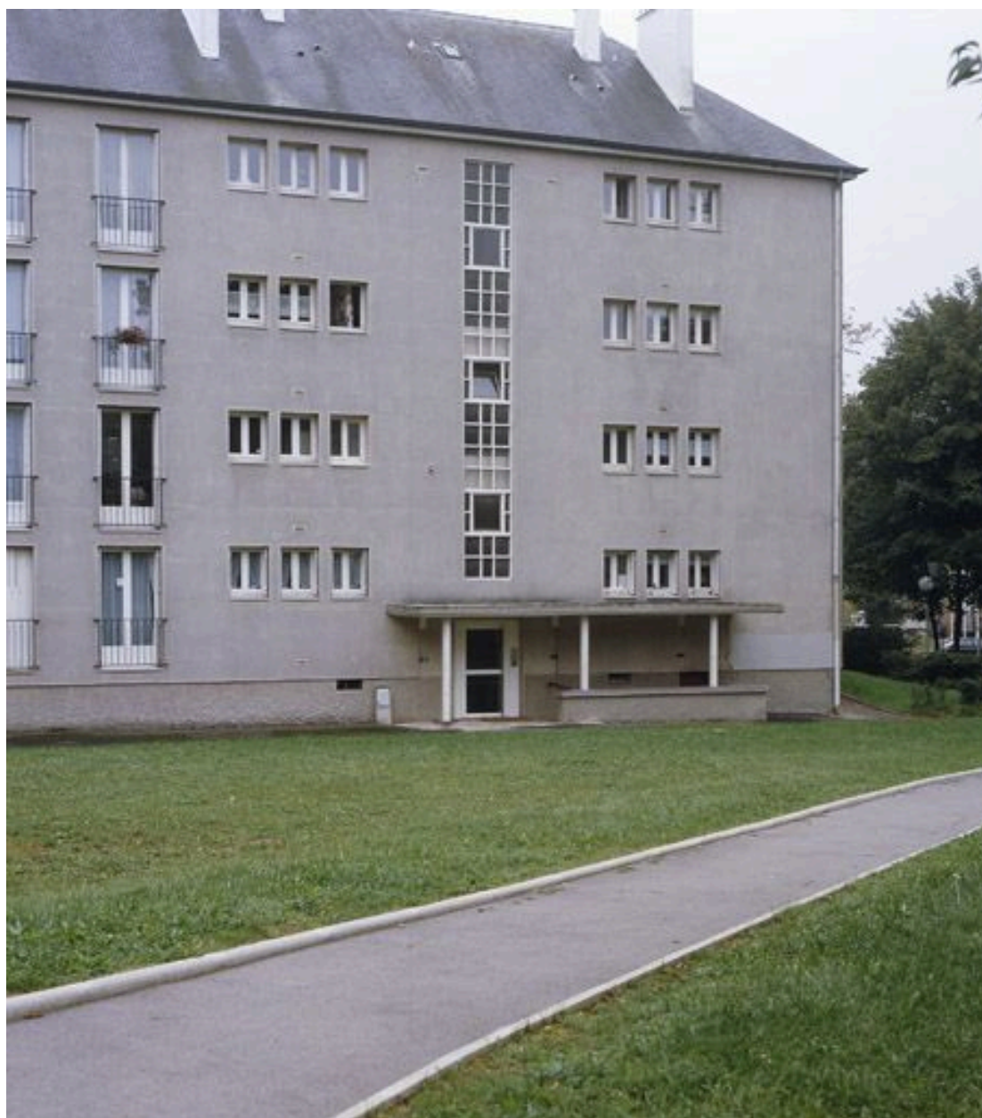
Détail d'une entrée d'immeuble.
