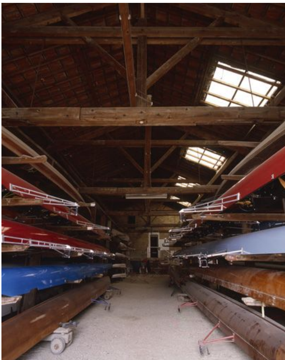
Vue de la travée centrale du second hangar à bateaux.
