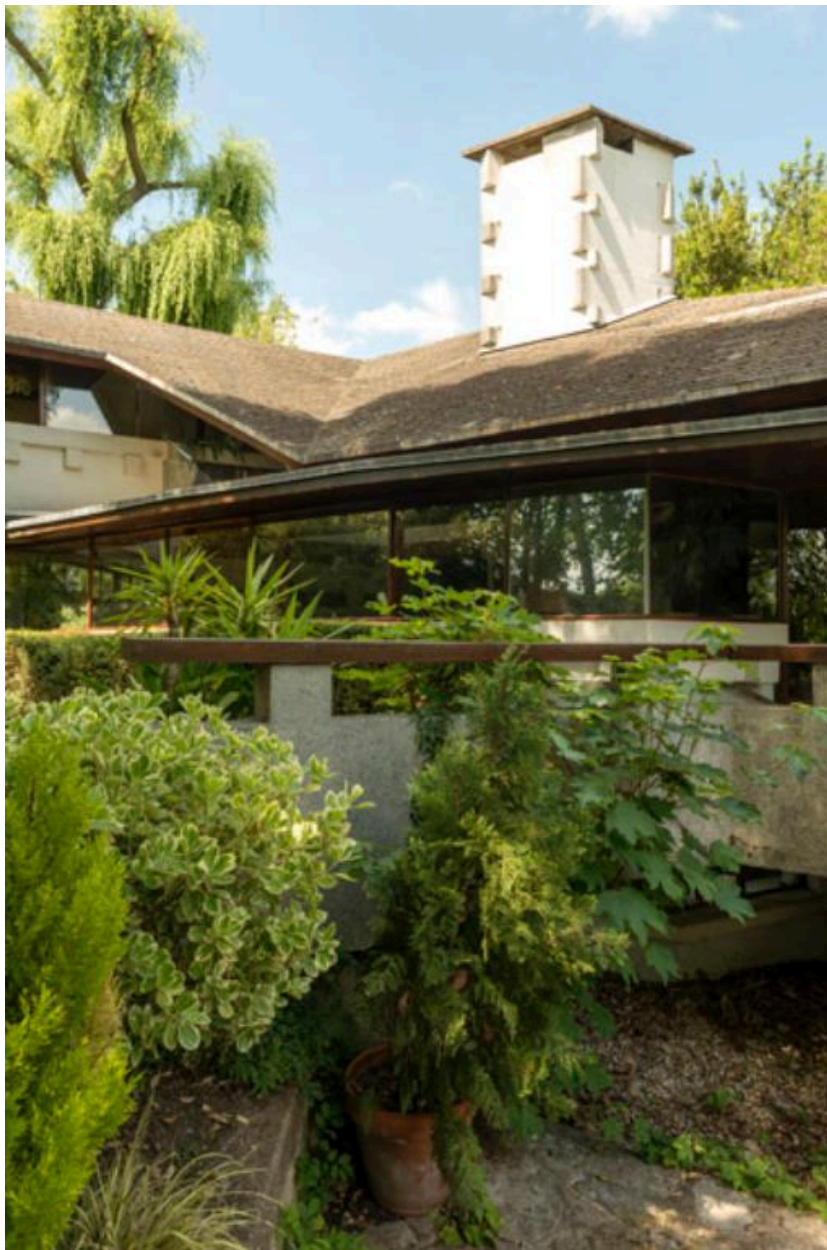
Vue rapprochée de la cheminée et de la toiture de l'aile principale.
